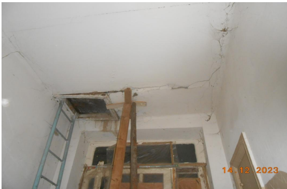
Նկ.5 Մասնաշենքի ձախակողմյա հատվածամասում տեղակայված սանդղավանդակի վերնածածկի վնասված սալի տեսքը
